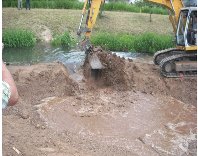
Gewässeröffnung zur Inbetriebnahme des 2. Bauabschnittes
