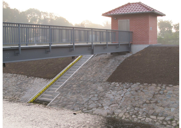
Der neue Hochwassermeldepegel Wasserthaleben an der Helbe, Betreiber TLUG
